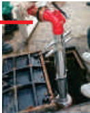
応急給水栓に応急の給水管をセット
