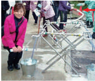
応急給水栓に応急の給水管をセット
